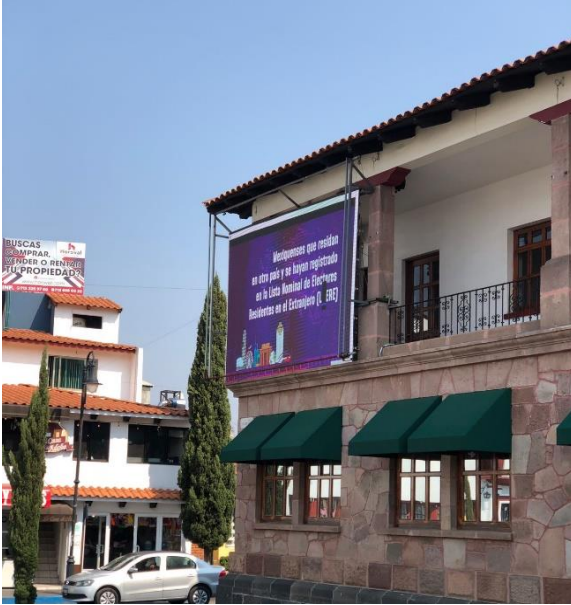
Plaza central "Isidro Fabela" en la fachada del palacio municipal Municipio: Atlacomulco
